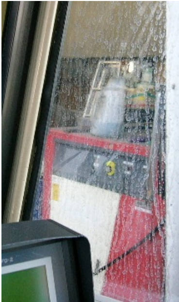
施工前：かなり加水分解進行の状態。
